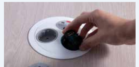
Setzen Sie den neuen Einsatz ein, beachten Sie bitte die Orientierung des Einsatzes in das blaue Gehäuse
